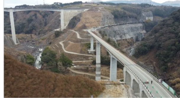
(d) Choyo bridge and New Aso-Ohashi bridge (back)
