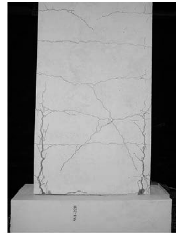
(d) Splice distress and shear cracks
